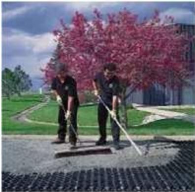
Pour and level aggregate fill
